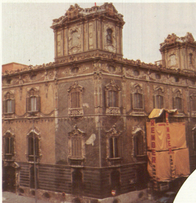
Restauración Palacio Marques de Dos Aguas - Valencia. Dr. Arquitecto D. Alfonso Fungairiño Nebot
