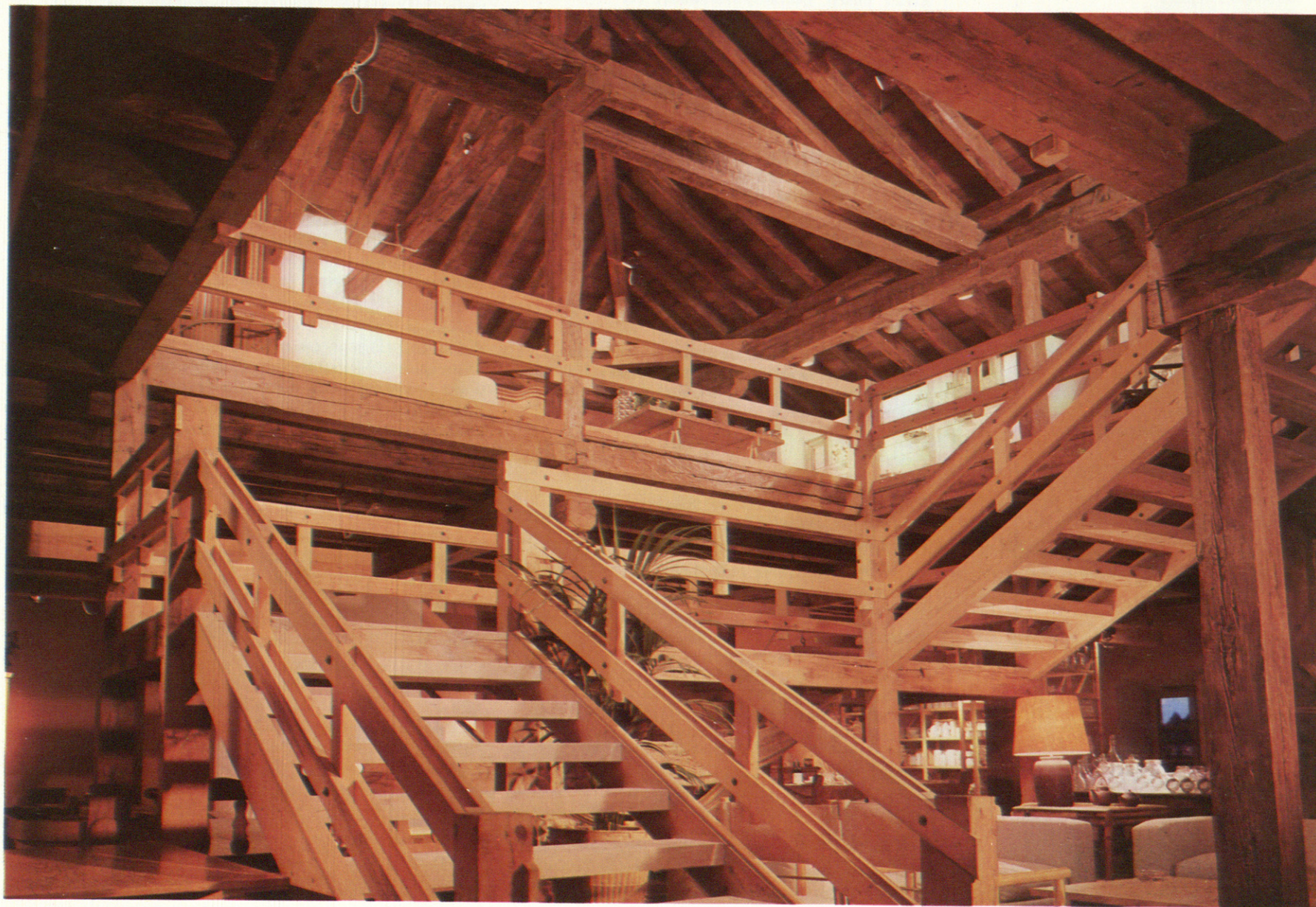
Restauración Casa Cuartel de la Guardia Civil, Pedraza (Segovia)
