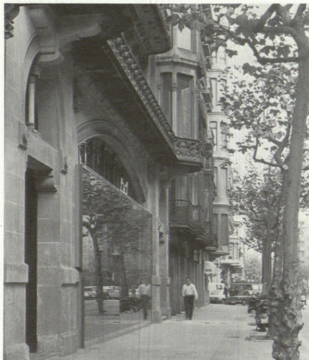
Detalle bajos, después de la restauración.
