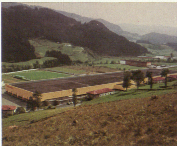
Pabellón industrial en Yurre (Vizcaya), cuya cubierta de 22.500 m. 2 de superficie, ha sido impermeabilizada con láminas de caucho butílico INDY.
