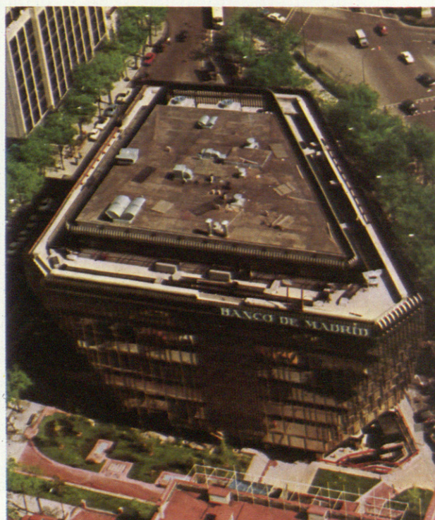
Terraza de 2.500 m. 2 de superficie, recubierta con láminas de caucho butílico INDY, perteneciente al edificio del Banco de Madrid (ahora la Caixa).
