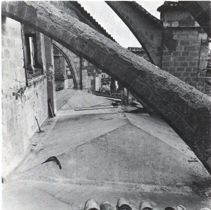
Cubiertas de la girola restauradas, en las zonas donde no se construyeron las pirámides de piedra.
