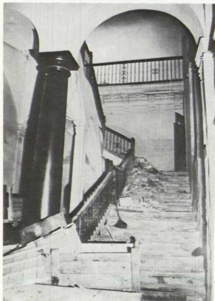
Arriba, el edificio en su estado anterior al proyecto, y abajo, durante la obra. A la derecha, axonométrica del concurso.
