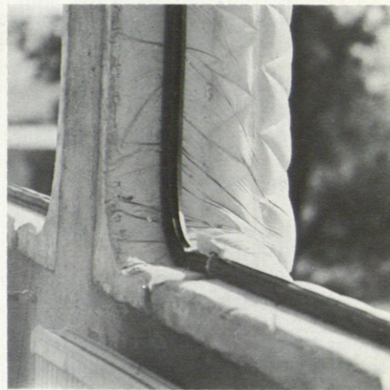
Ventanal. El cerco de neopreno queda empotrado en el hormigón.
