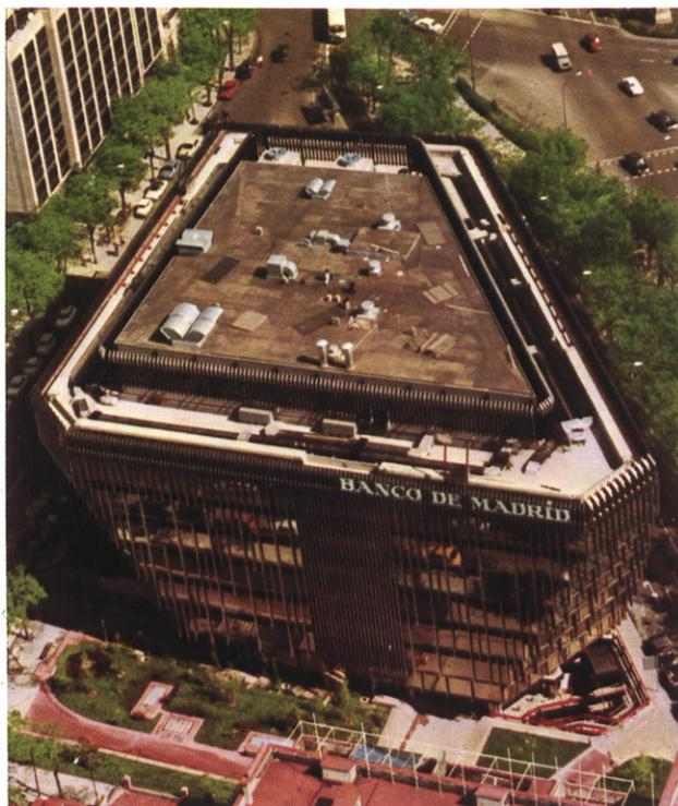
Terraza de 2.500 m.<sup>2</sup> de superficie, recubierta con láminas de caucho butílico INDY, perteneciente al edificio del Banco de Madrid (ahora la Caixa).
