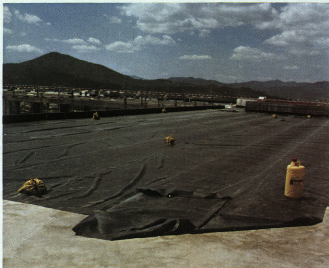
Hospital General de Cataluña. 24.000 m. 2 de láminas de Butilo, en terrazas cubiertas invertidas y jardinería.
