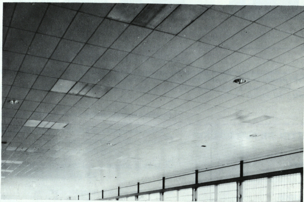
FALSO TECHO PLADUR DE ESTRUCTURA VISTA
