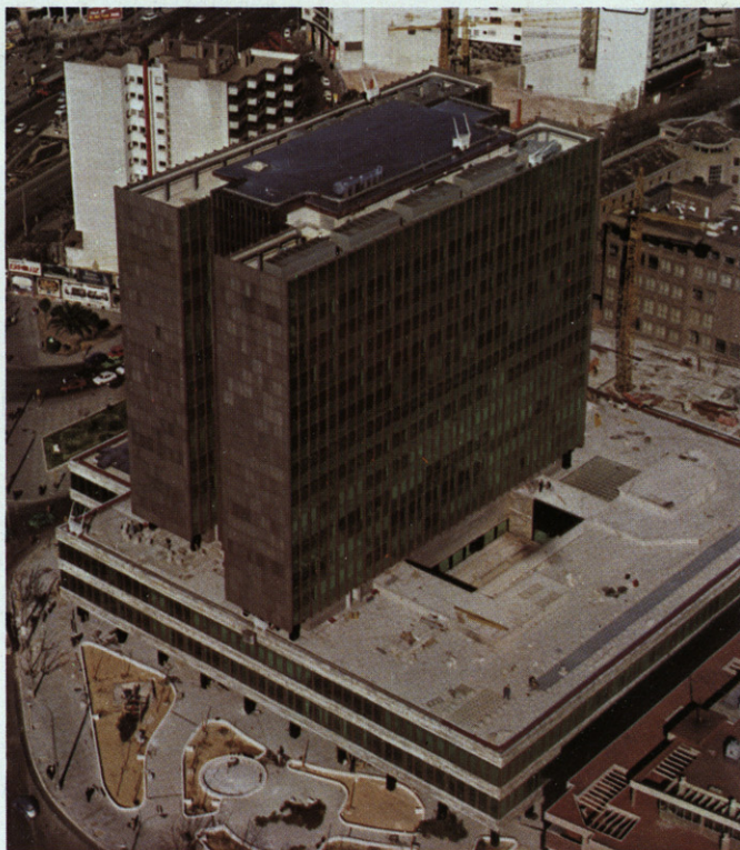
Caja de Ahorros de Zaragoza, Aragón y La Rioja. Edificio de la Plaza Paraíso en Zaragoza. 10.000 m. 2 de láminas e Butilo en terrazas cubiertas, zonas jardín, parking y helipuerto.
