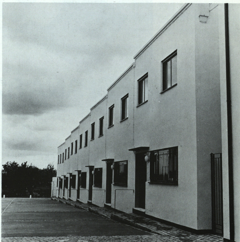
Diversos aspectos del conjunto.
