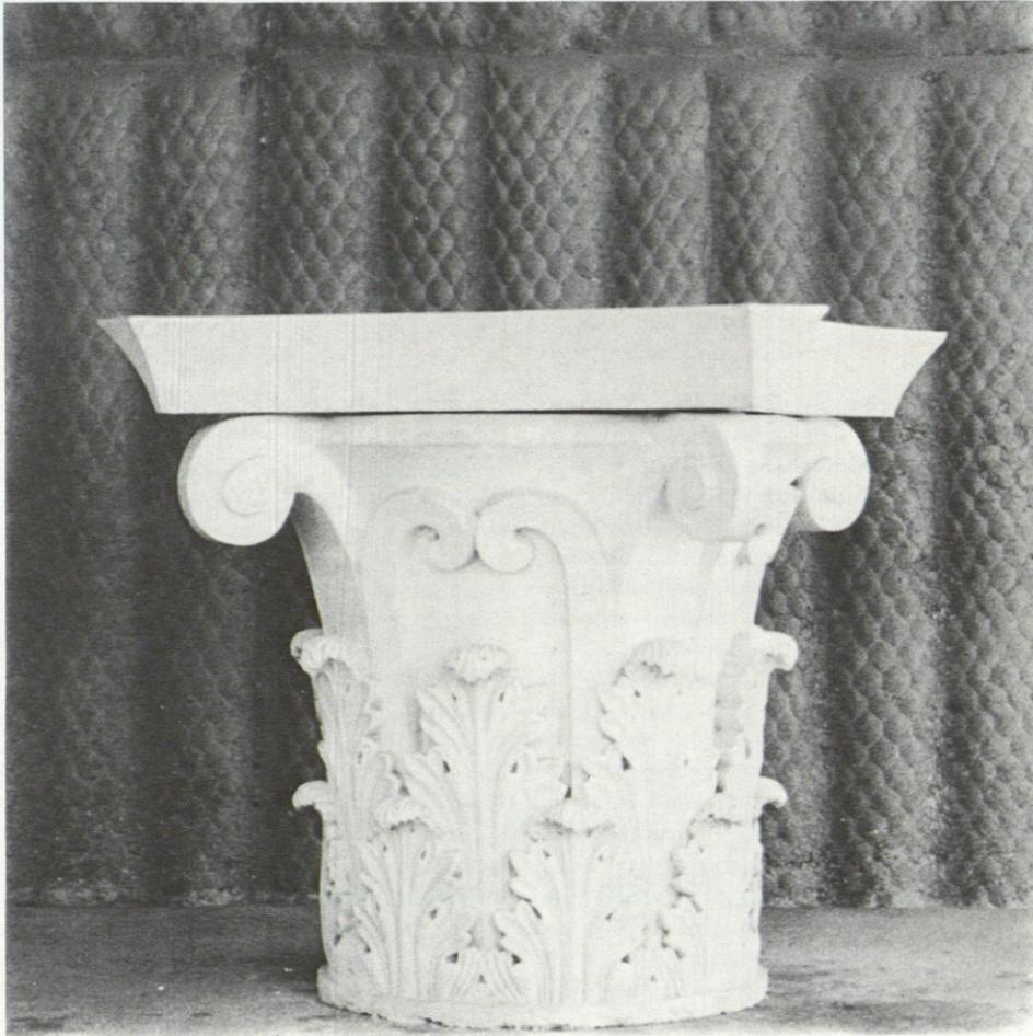
*Modelo en escayola de capitel corintio realizado por Fisac para el Edificio Central del Consejo Superior de Investigaciones Científicas (1943). Al fondo, el muro de hormigón de su propio estudio construido con encofrados flexibles (1971).*
