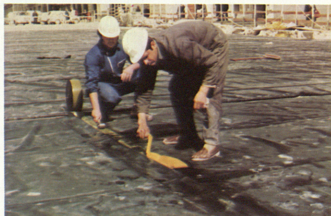
Detalle de empalme en frío de las láminas. La facilidad de instalación es característica del caucho butílico INDY.
