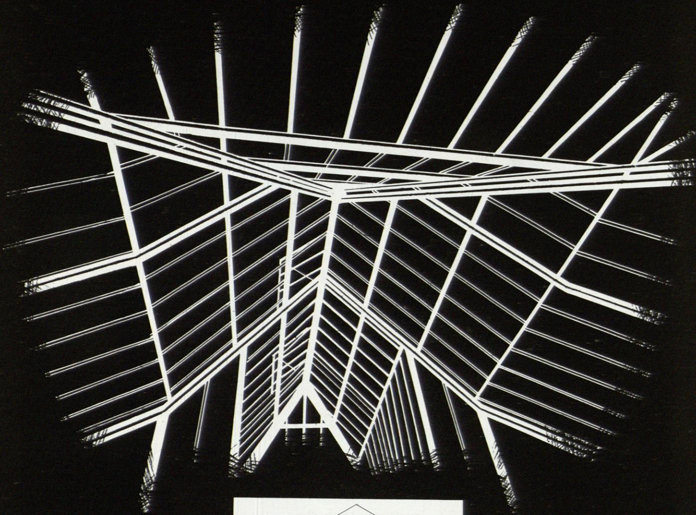
Los perfiles patentados Hiberlux en aluminio constituyen la armadura portante y mantienen el acristalamiento.
