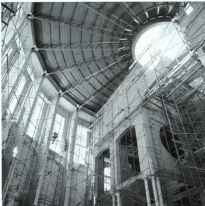
8. Apeos en obra.
