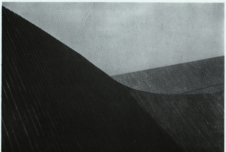
15. Ampliación Escuela de Arquitectura. Barcelona. (Foto: O. Mestre).
