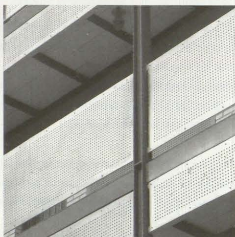
2. DETALLE. GALERÍAS INTERIORES. EDIFICIO DE VIVIENDAS EN LA GRAN VÍA DE S. FRANCISCO.
