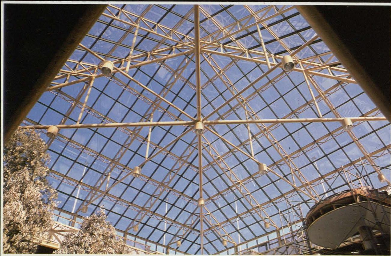
Los perfiles patentados Hiberlux en aluminio constituyen la armadura portante y mantienen el acristalamiento. Una junta en neopreno mantiene el aislamiento térmico. El perfil posee canales para drenar el agua de condensación.
