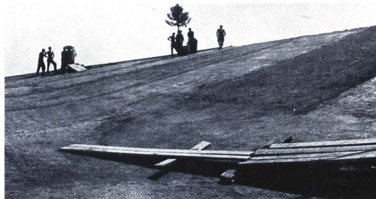
Cubierta de Ronchamp durante la construcción. Roof of Ronchamp during construction.
