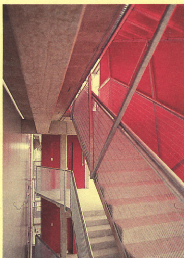
Helmut Richter. Edificio de viviendas, Viena, 1986-1990.
