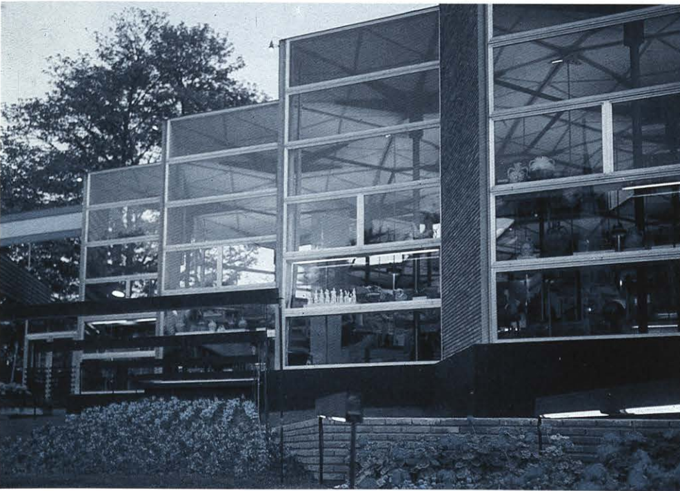
Exterior e interior del Pabellón de España en la exposición de Bruselas, 1957, de los arquitectos españoles Corrales y Vázquez Molezón, ejemplo de obra maestra, una de tantas no permanentemente difundidas.
