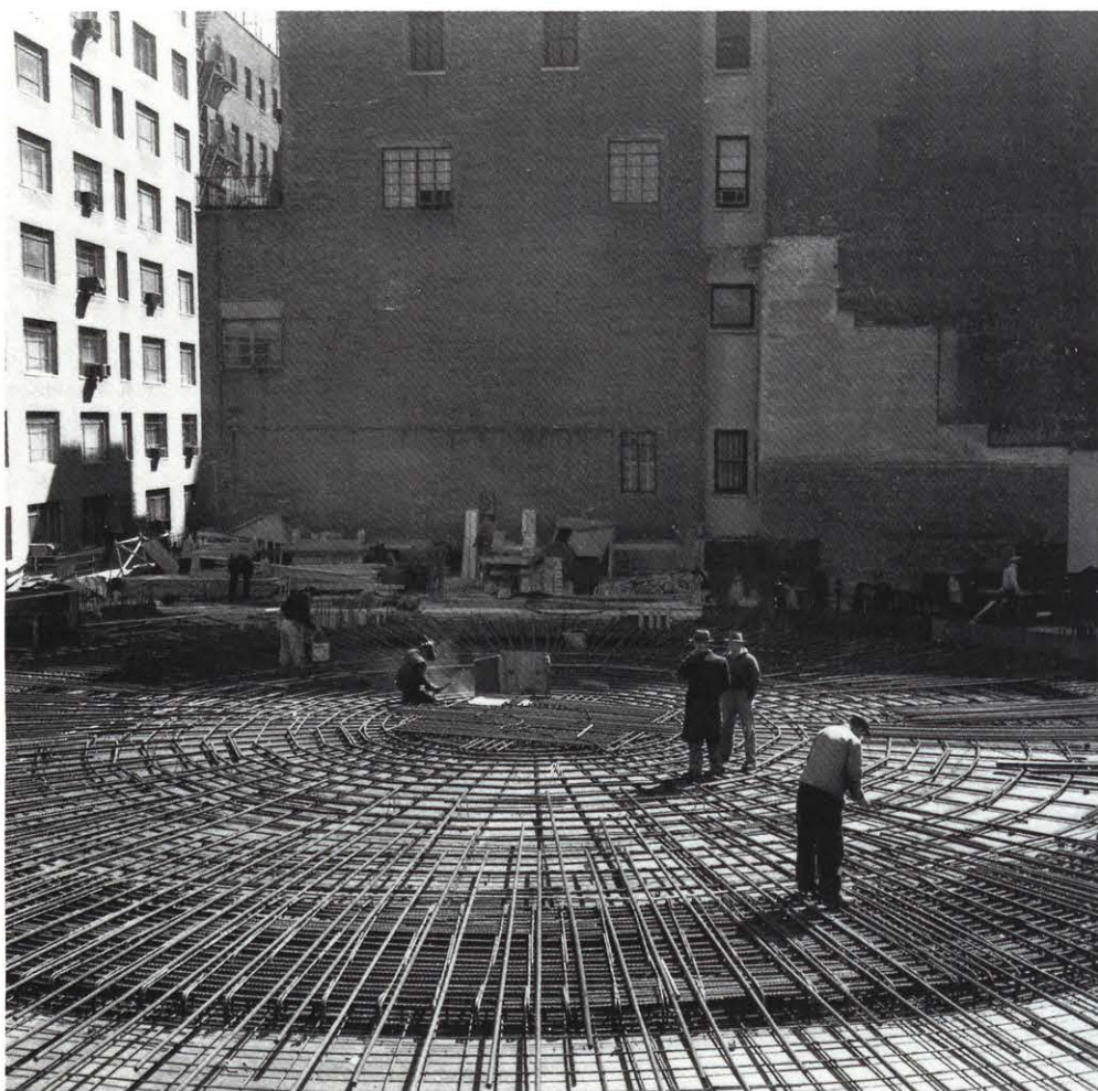
Colocación de los redondos de refuerzo. Layout of reinforcing bars. Foto: William Short.
