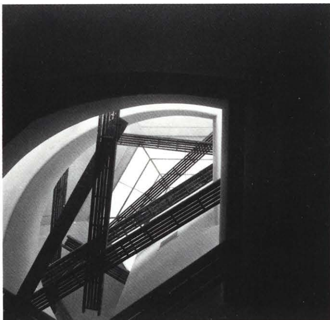
Andamiaje bajo el lucernario. Scaffolding at monitor. Foto: William Short.
