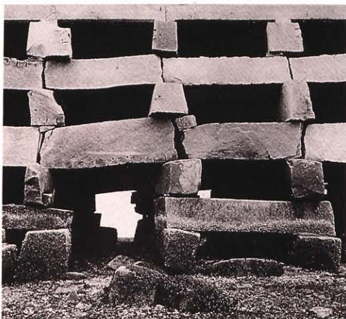
14 Bailey Island Bridge. Harpswell, Maine. Puente de piedra, 1928. Llewellyn N. Edwards, ingeniero.
