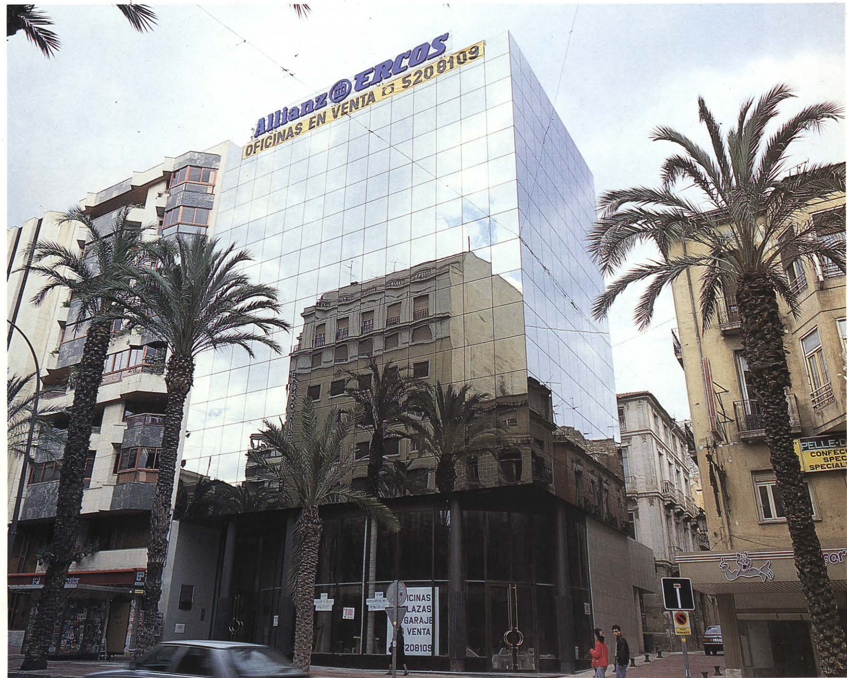
Edificio Espacio - Alicante
