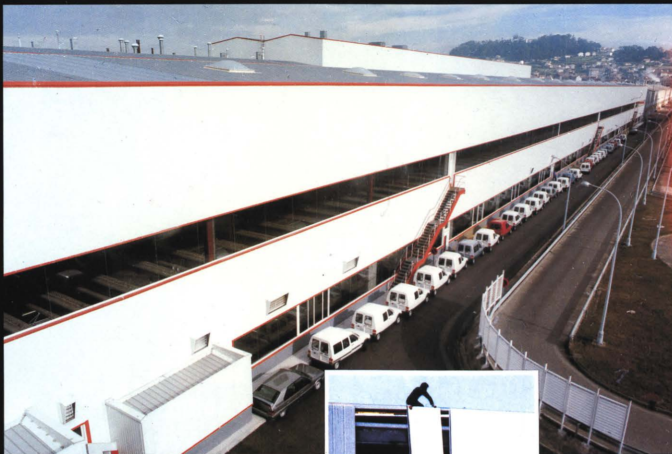
Nave de Pintura-Citroen-Vigo
