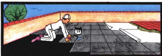
AISLAMIENTO DE PUENTES TERMICOS: solamente pegar y guarnecer
