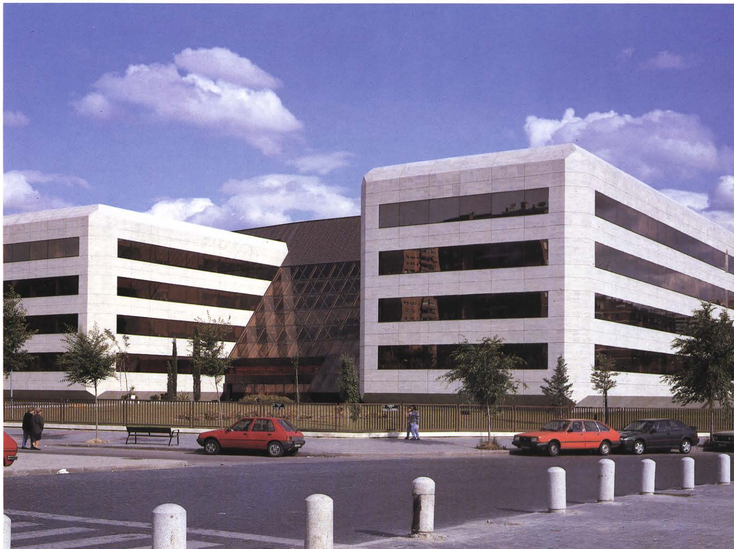
EDIFICIO INSERSO. MINISTERIO DE ASUNTOS SOCIALES (MADRID) ARQUITECTO: D. Rafael de la Hoz Arderius
