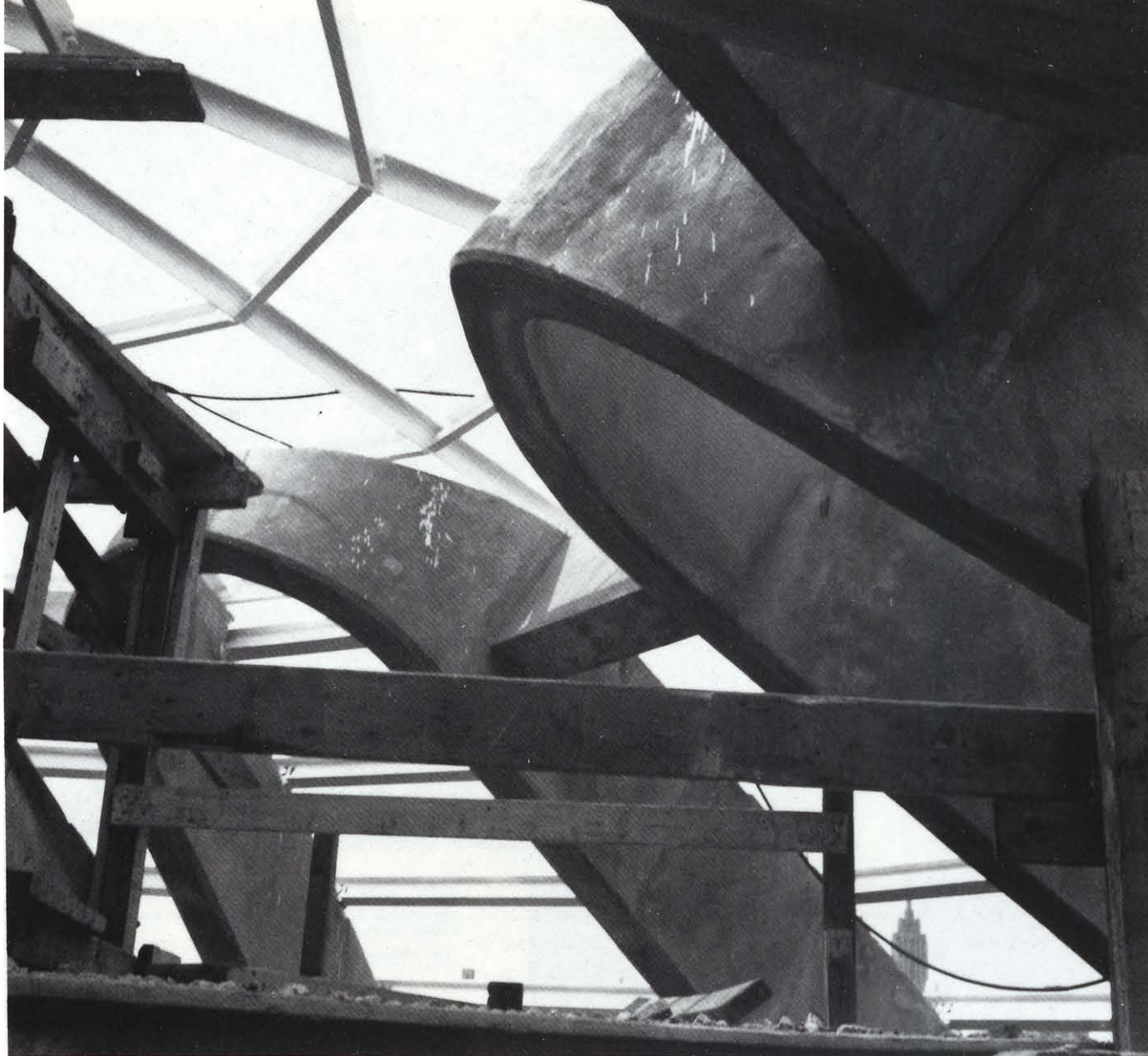
El Museo Solomon R. Guggenheim durante la construcción. Estructura del lucernario. The Solomon R. Guggenheim Museum under construction. Skylights ribs. Foto: William Short.
