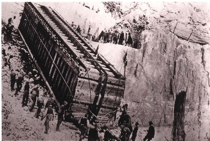
13 Cava Carbonara, Carrara. Extracción y traslado de un bloque de mármol para el Nuevo Forum de Roma, 1929.
