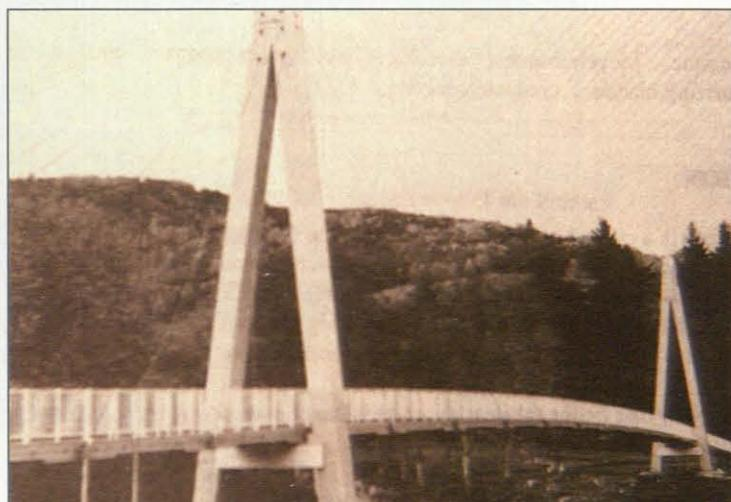
A la izquierda, viga de 125 metros de luz, construida totalmente con poliéster reforzado con fibra de vidrio. A la derecha, puente peatonal de Abnerfeldy, realizado con poliéster y fibra de vidrio.
