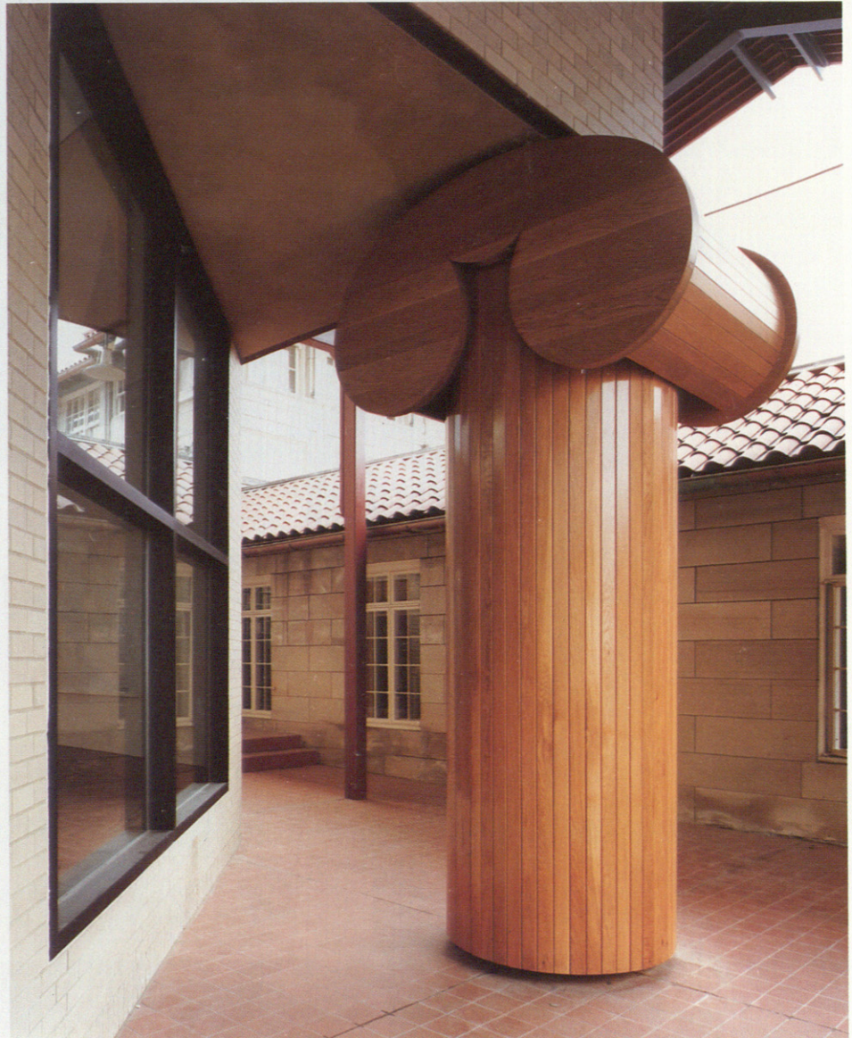
Detalle de la ampliación.
