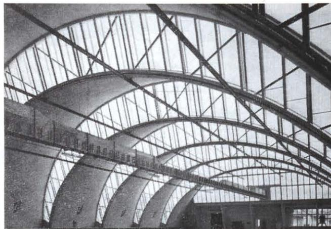
Interior de la catalogada nave industrial de Gosau. Reducido canto laminar formando sección resistente mixta con los entramados metálicos. Estructura proyectada por Hossdorf en 1954.
