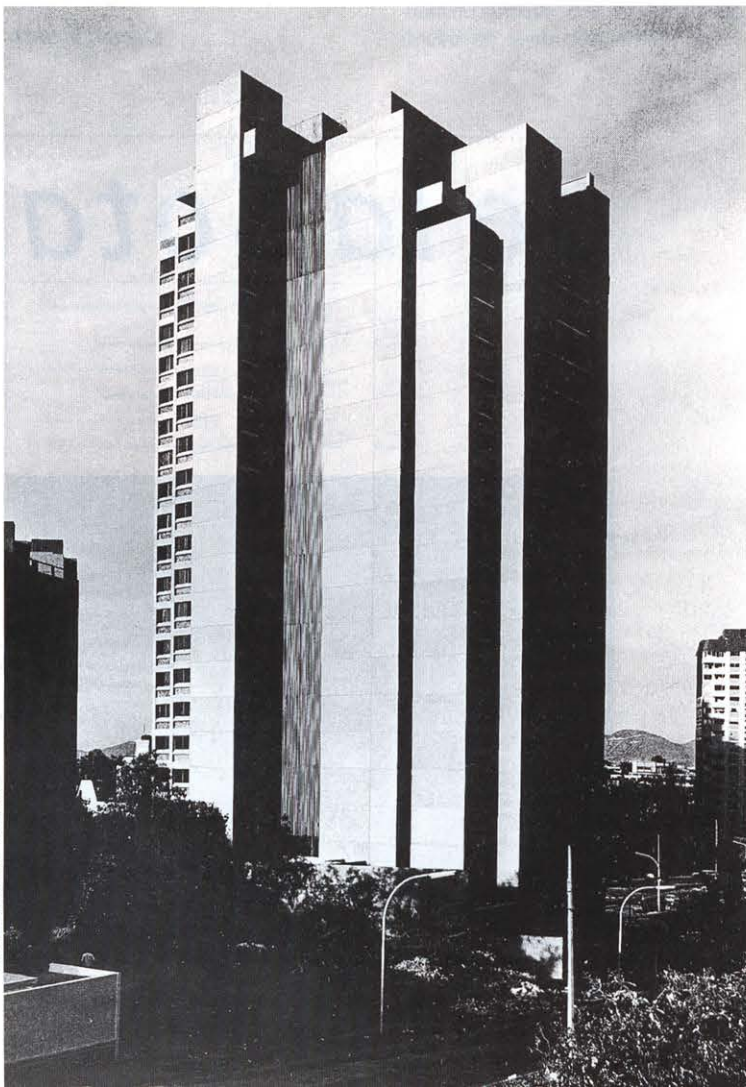
Edificio de departamentos. Torre Manhattan (1975). Arqs: Abraham Zabludovsky y Teodoro González de León. Vista de la fachada sudoeste.
