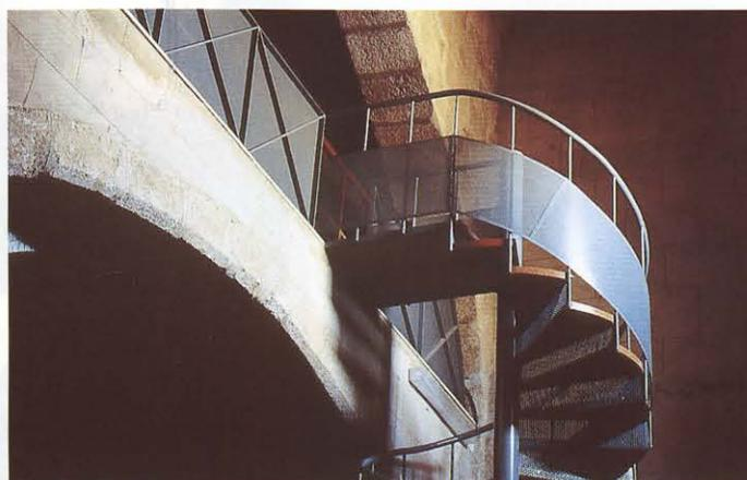
Detalle de la conexión de la escalera con el coro alto.
