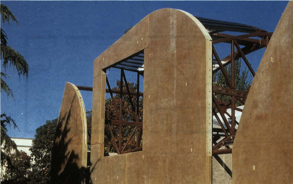
Construcción de la cubierta de acero
