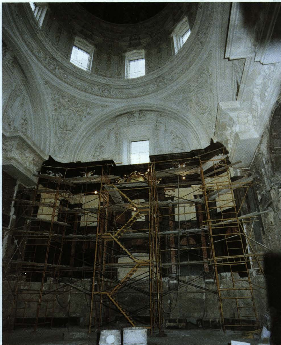
Uno de los lados de la capilla durante la reconstrucción. Octubre de 1988.
