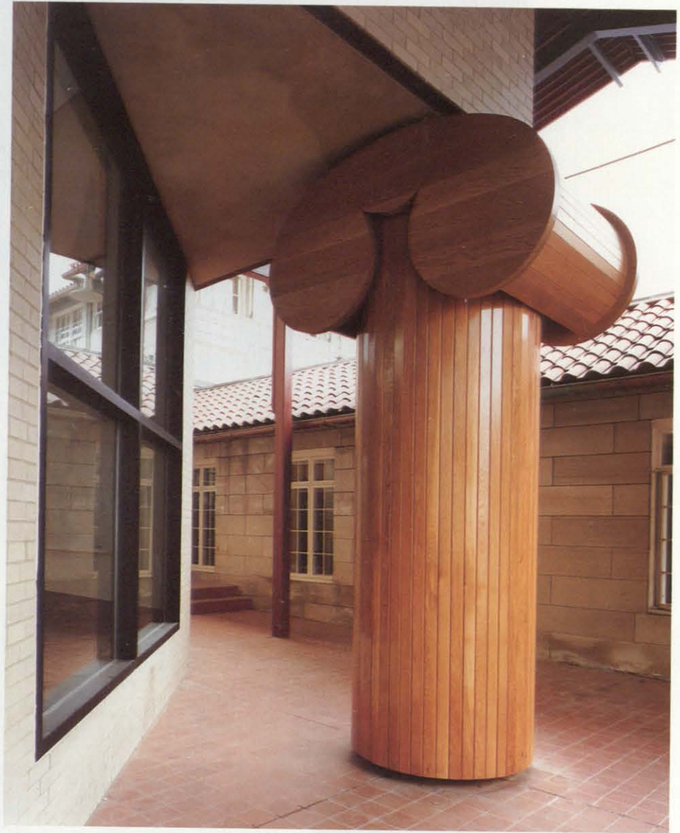
Detalle de la ampliación.
