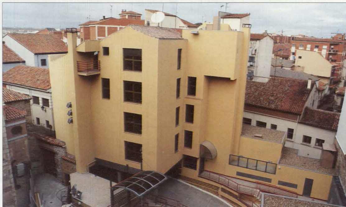
Vista interior del conjunto.
