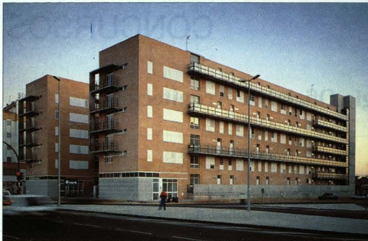
Edificación de 70 viviendas, en c/ Amor, de Sevilla.
