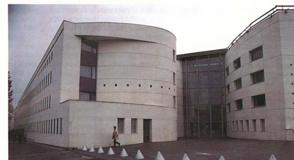
Sobre estas líneas, la "Ciudad de la Música". Vista de la Avenida de Jean Jaurès desde el bloque oriental. A la izquierda, "Parque de la Villette". Dos de las muchas Folies que crean una trama cuadrangular sobre el parque.
