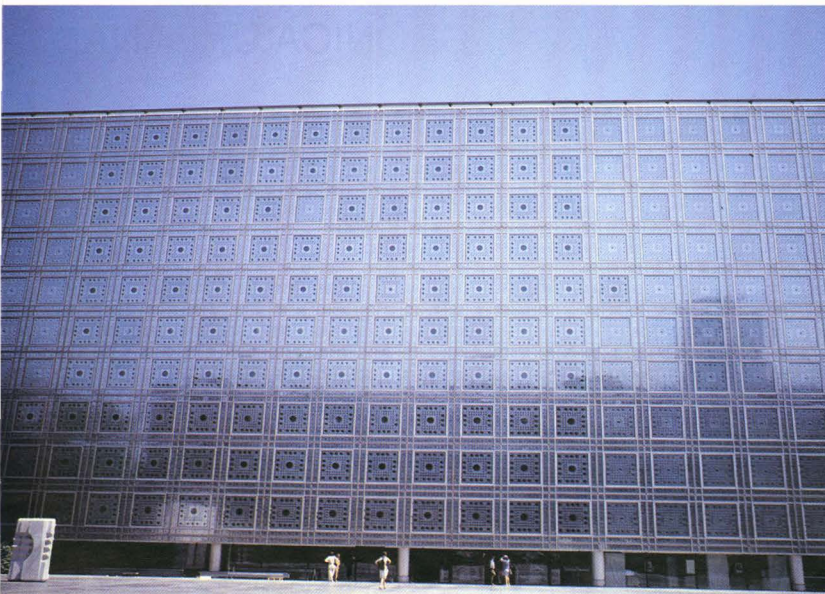
Instituto Árabe. Fachada Sur construida a base de paneles de aluminio con motivos geométricos árabes; contienen 24.000 diafragmas que se abren y cierran mediante células fotoeléctricas para controlar la potente luz natural.
