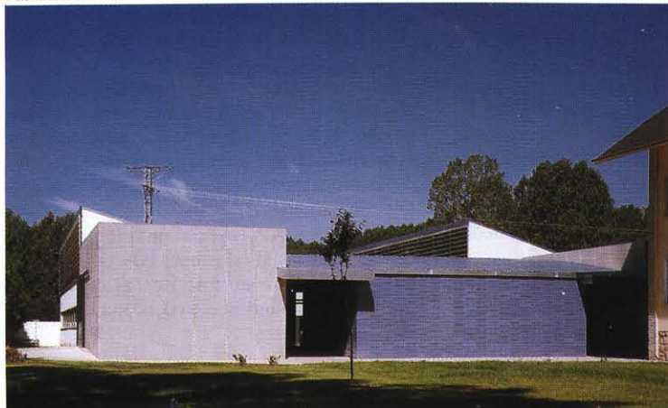
Fachada de acceso
