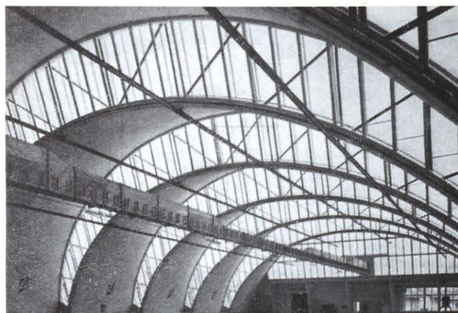
Interior de la catalogada nave industrial de Gosau. Reducido canto laminar formando sección resistente mixta con los entramados metálicos. Estructura proyectada por Hosssdorf en 1954.
