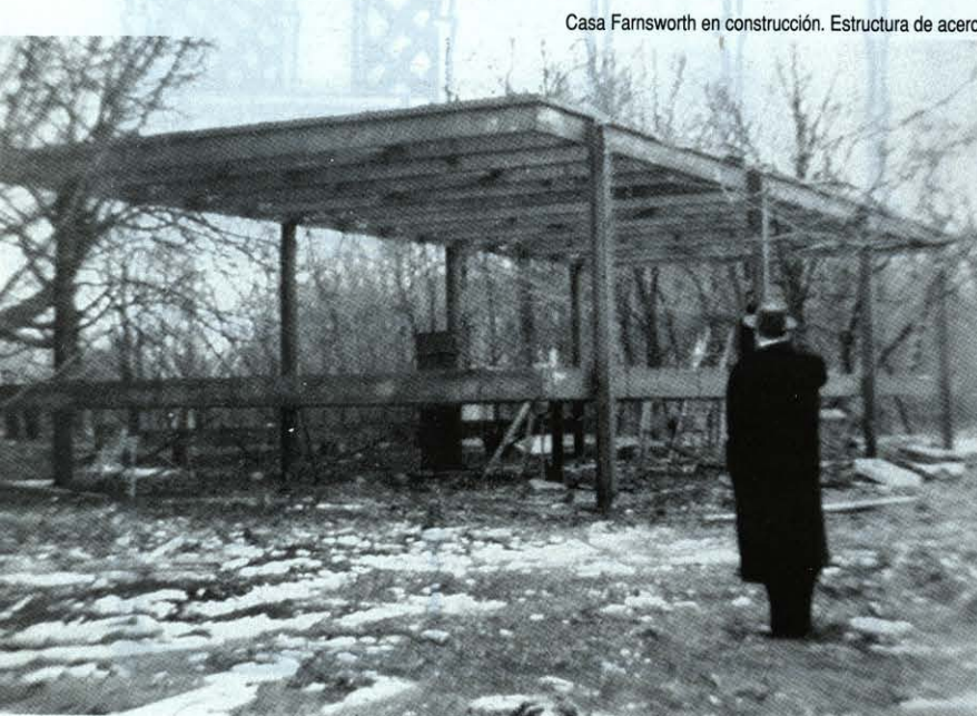
Casa Farnsworth en construcción. Estructura de acero
