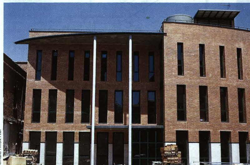
Entrada al aulaio
