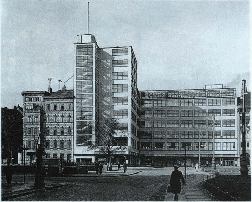
Edificio de oficinas Berlin, M. Taut 1931-32
