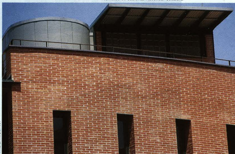
Remates de cubierta. Ascensor-escalera
