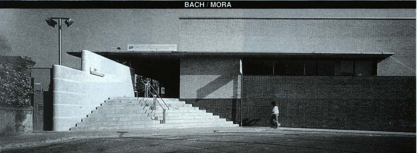
Estación de Sabadell. 1989-93
