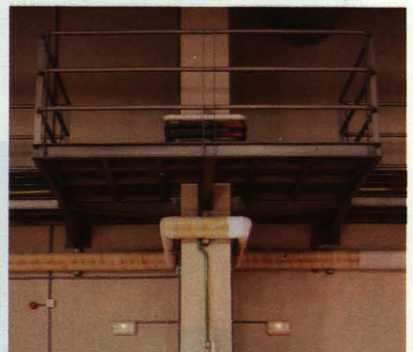
Interior del centro de investigación e instrumentación.
