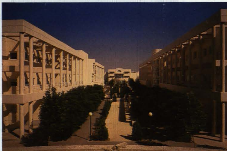
Vista panorámica del paseo central del Campus.
