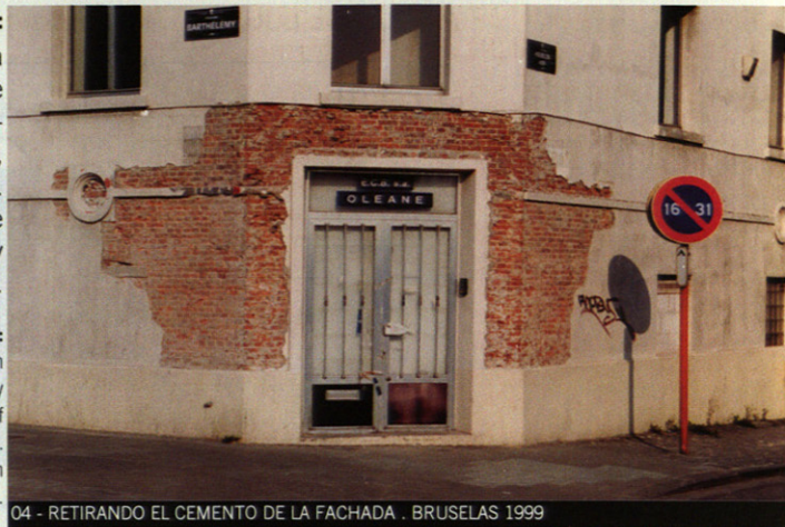
04 - RETIRANDO EL CEMENTO DE LA FACHADA . BRUSELAS 1999
