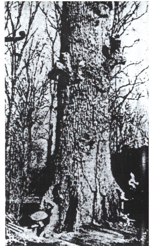
11 - CHIMENEA EN FORMA DE ÁRBOL. REALIZADA EN HORMIGÓN ARMADO EN MALMAISON, PARÍS, ALREDEDOR DE 1900.
