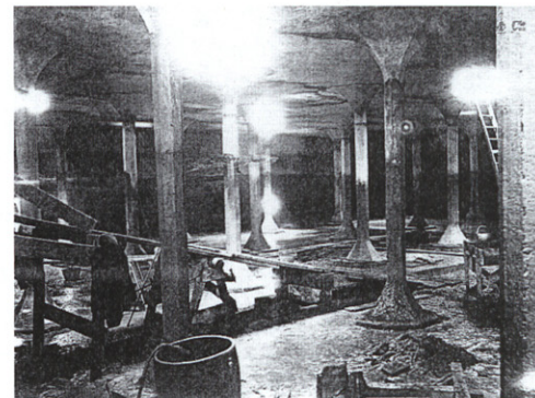
17 · ROBERT MAILLART. CONSTRUCCIÓN DE UNA PLANTA DE TRATAMIENTO DE AGUAS, RORSCHACH, 1912.
