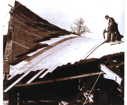
64 · VIVIENDA UNIFAMILIAR. COLOCACIÓN DE TABLAS CURVAS
