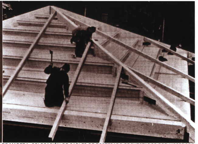
59 · PABELLÓN DE MADERA. COLOCACIÓN DE CABLES DE POSTENSADO PROYECTADOS POR HOSSDORF
