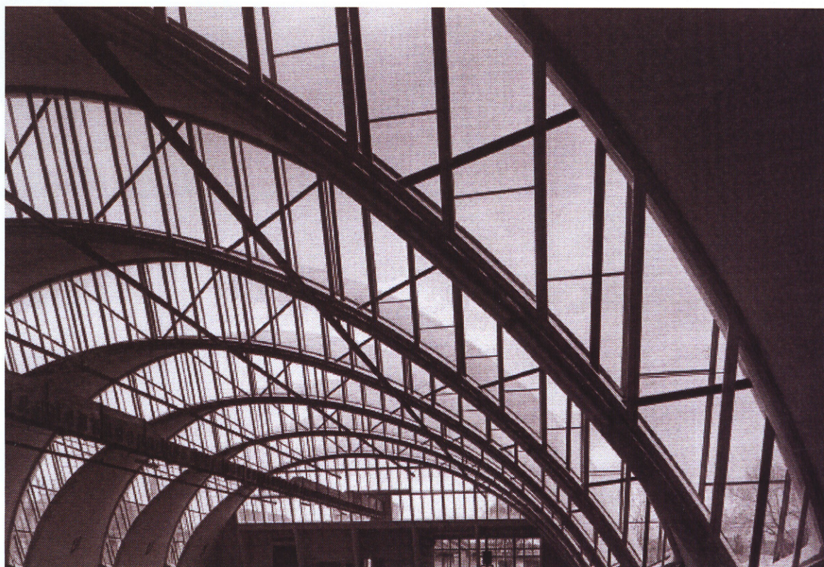
22 - INTERIOR DE LA NAVE INDUSTRIAL DE GOSSAU. CANTOS MIXTOS PROYECTADOS POR HOSSDORF OPTIMIZANDO EL ESPESOR DE LA ESTRUCTURA LAMINAR A FAVOR DE LA PENETRACIÓN DE LA LUZ NATURAL.
