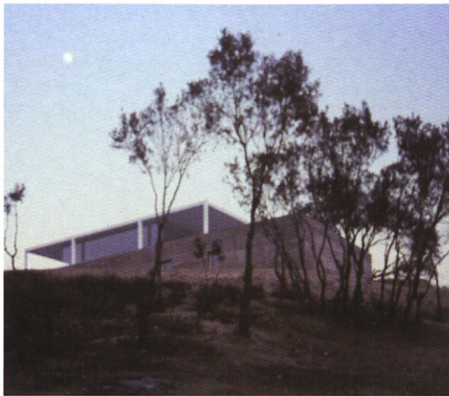
02 · PREMIO EX AEQUO: VIVIENDA UNIFAMILIAR EN SEVILLA LA NUEVA, MADRID, DE ALBERTO CAMPO
