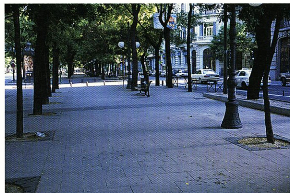
04 - CONSOLIDACIÓN DE FALTAS EN EL PLANTÍO POR EL PAVIMENTO DE LA PRIMERA FASE
