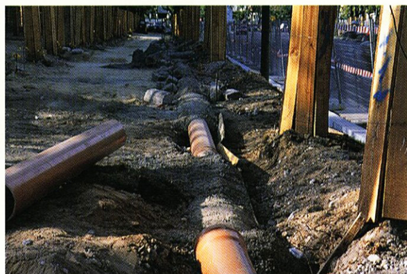
06 - ZANJA HORMIGONADA TANGENTE A UNA FILA DE ÁRBOLES
