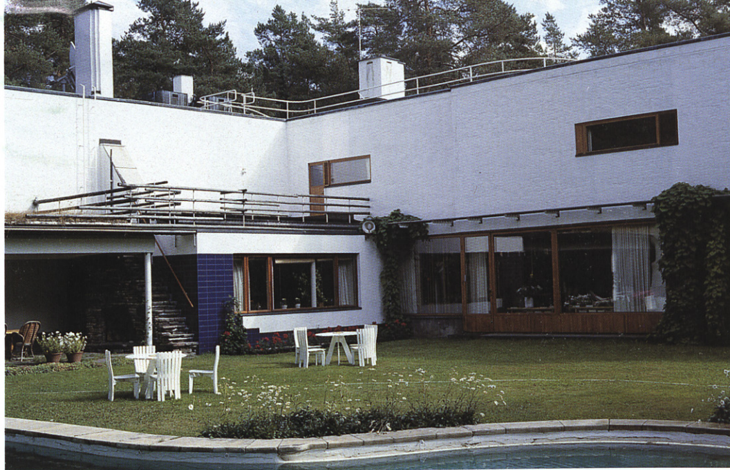
04 · VISTA DEL PATIO JARDIN DE VILLA MAIREA
