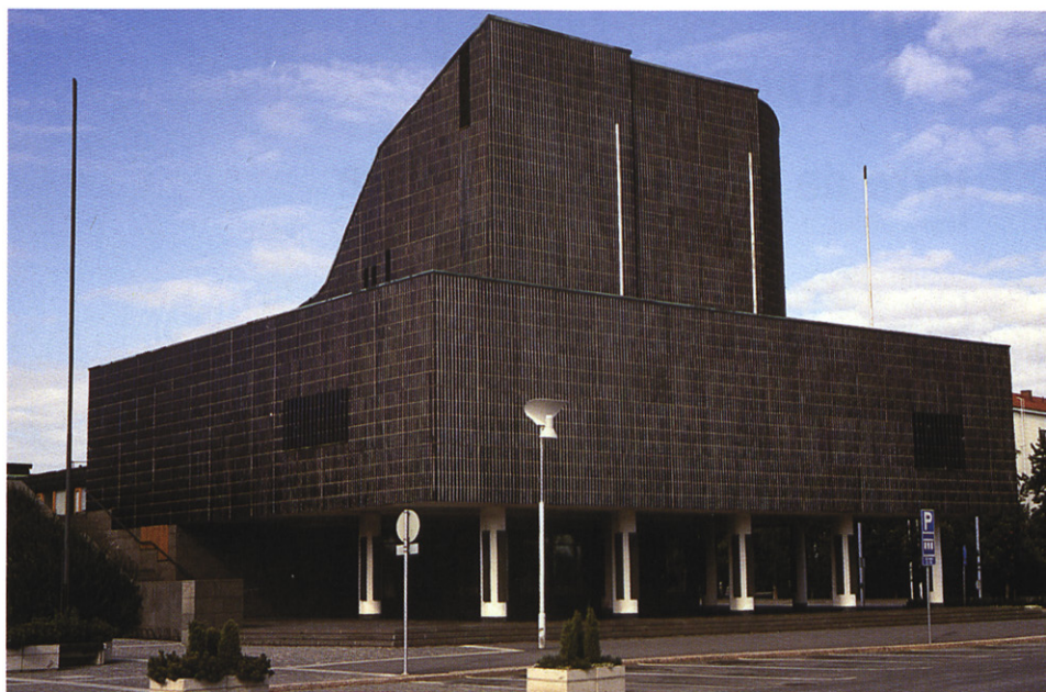
08 · SOPORTES DEL "ORDEN FINLANDES", REVESTIDOS CON CERAMICA, EN EL AYUNTAMIENTO DE SEYNÄJOKY
