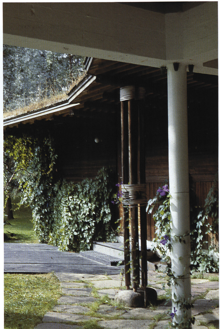
07 - SOPORTE DE LA "CABAÑA" (SAUNA), COMPUESTO DE TRONCOS REALES ATADOS CON CUERDAS Y SOPORTE CILINDRICO CORBUSERIANO.
