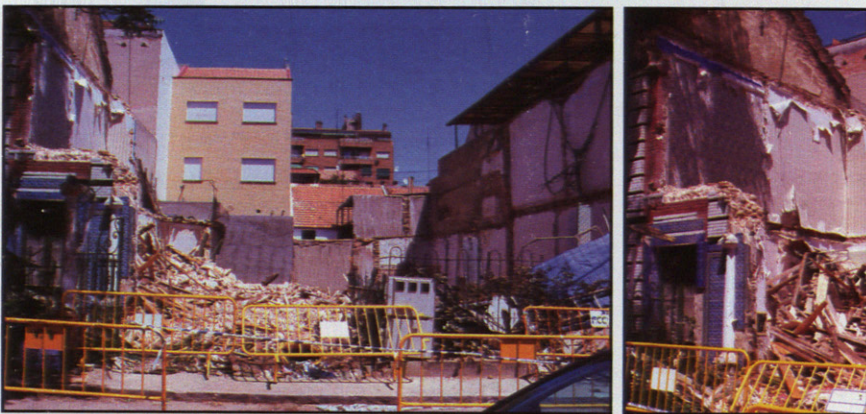
07 · DOS VISTAS DE LOS EDIFICIOS DEMOLIDOS EN LA CALLE DE CASTELAR (JUNIO 2003)
