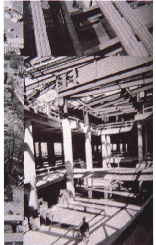
07 - ATRIO EN CONSTRUCCIÓN DE ARONOFF
