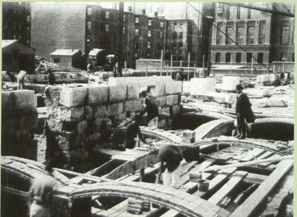
i9 CONSTRUCCIÓN DE ARCOS TABICADOS EN LA BIBLIOTECA DE BOSTON. EL HOMBRE DE PIE SOBRE UNO DE LOS ARCOS ES RAFAEL GUASTAVINO
