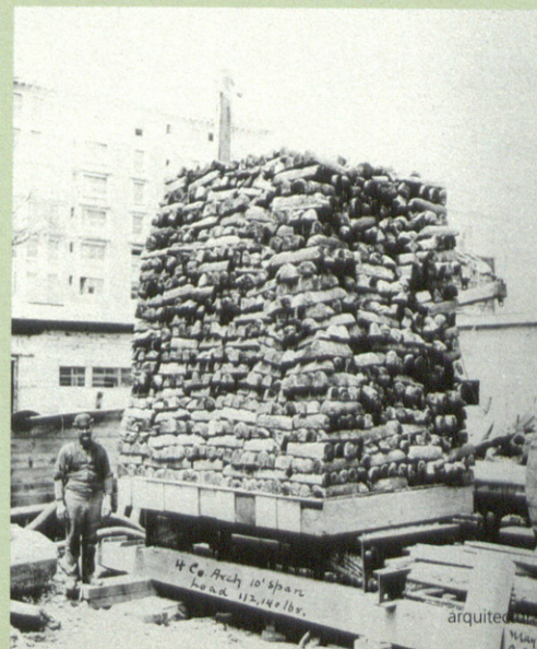
i12 ENSAYO DE RESISTENCIA SOBRE UNA BÓVEDA DE CAÑÓN TABICADA (1901)
