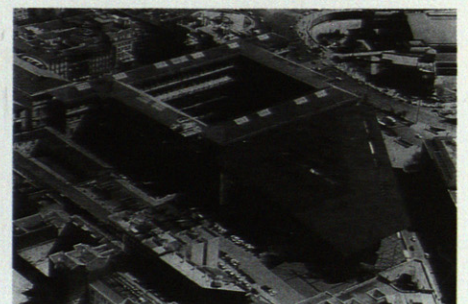
259 - VISTA AEREA DE LA AMPLIACIÓN
