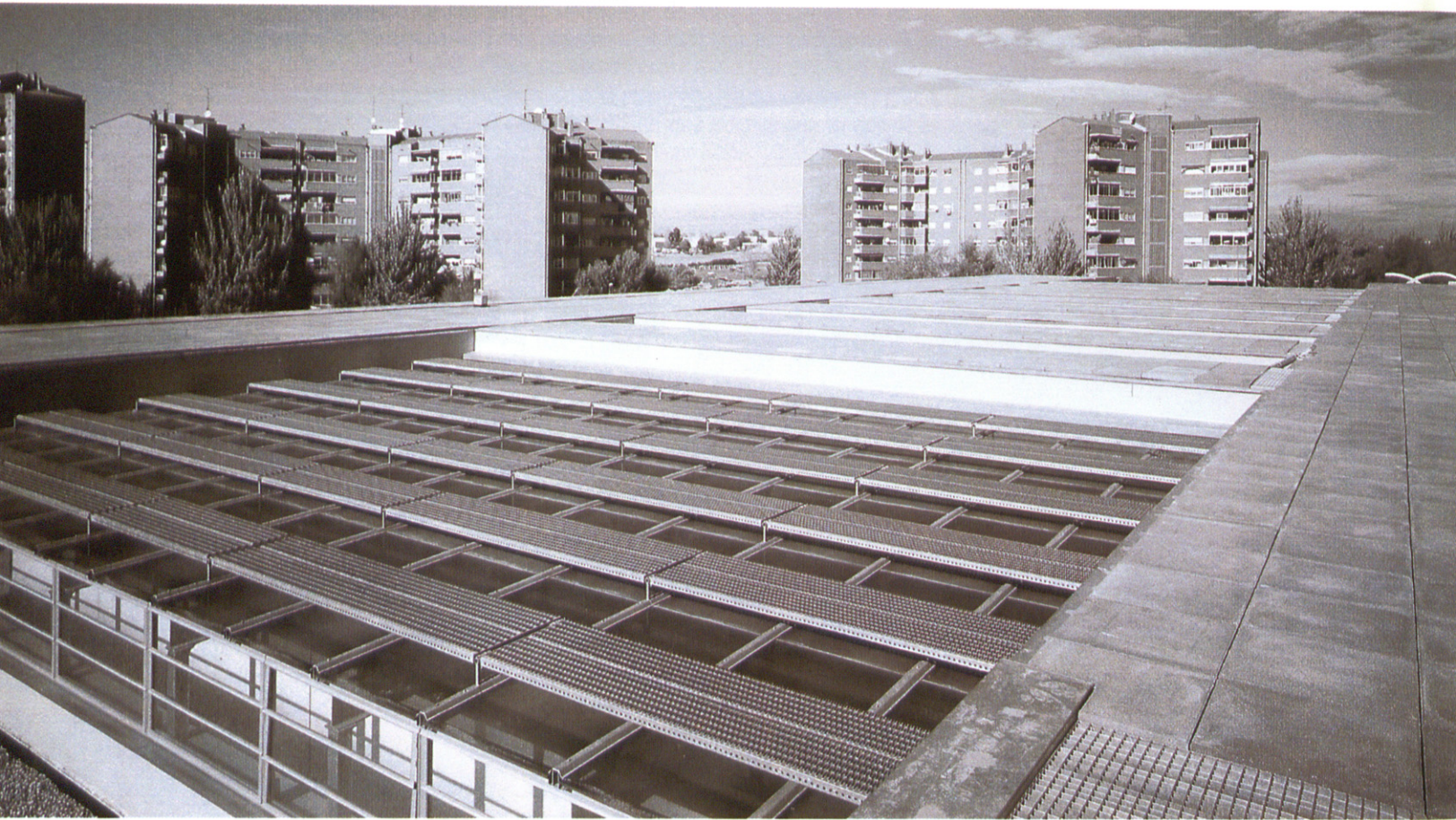
43 · DETALLE DE LA CUBIERTA
