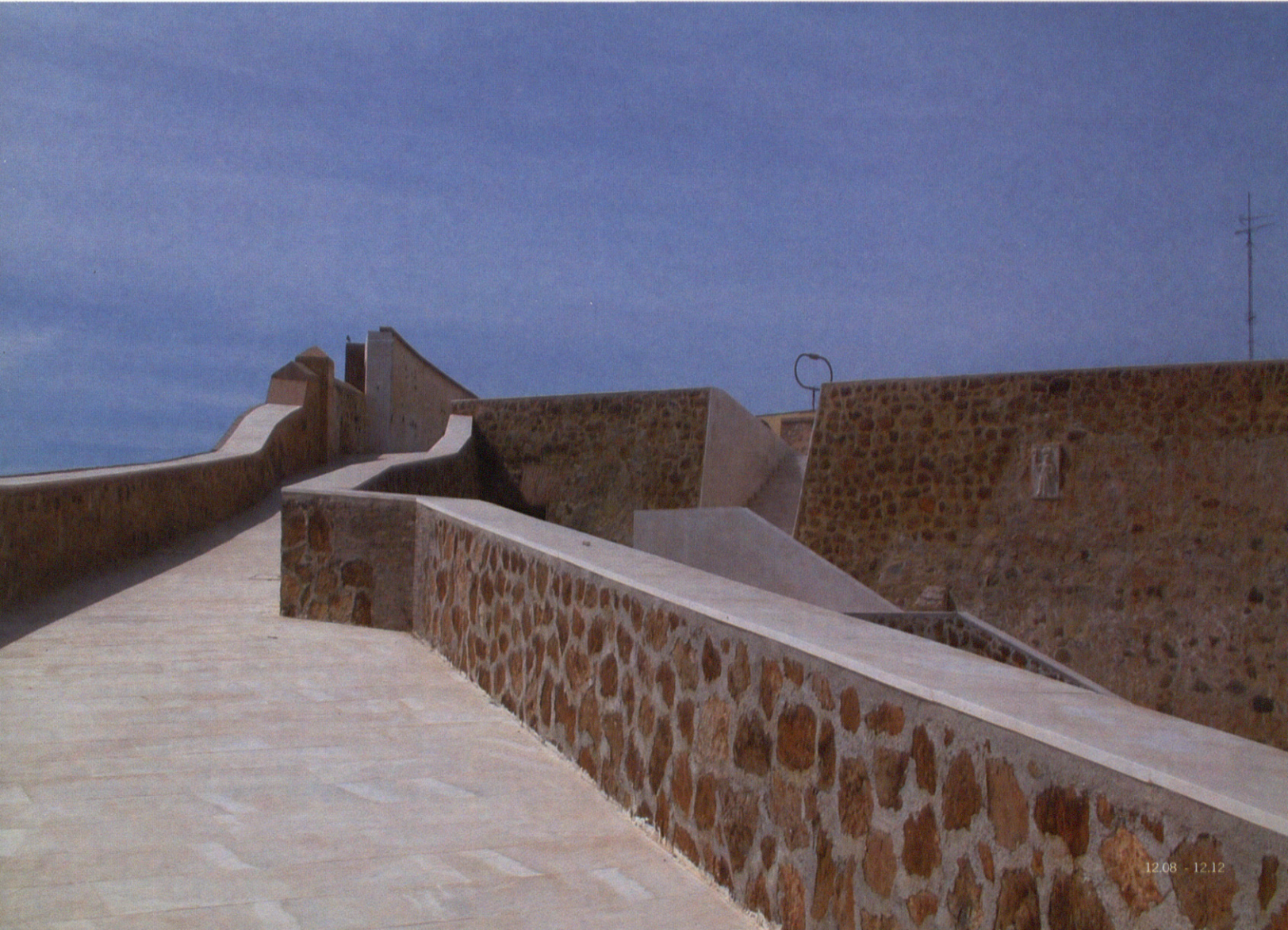
12- DETALLE DE LA RECONSTRUCCIÓN DE LA MAMPOSTERÍA DE LAS MURALLAS
