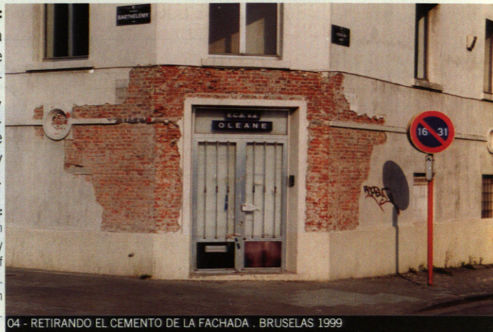
04 - RETIRANDO EL CEMENTO DE LA FACHADA . BRUSELAS 1999
