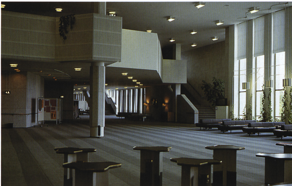
09 · DOS EJEMPLOS DE SOPORTES REVESTIDOS CON PLACAS DE PIEDRA EN EL INTERIOR DEL PALACIO DE CONGRESOS DE HELSINKI.
