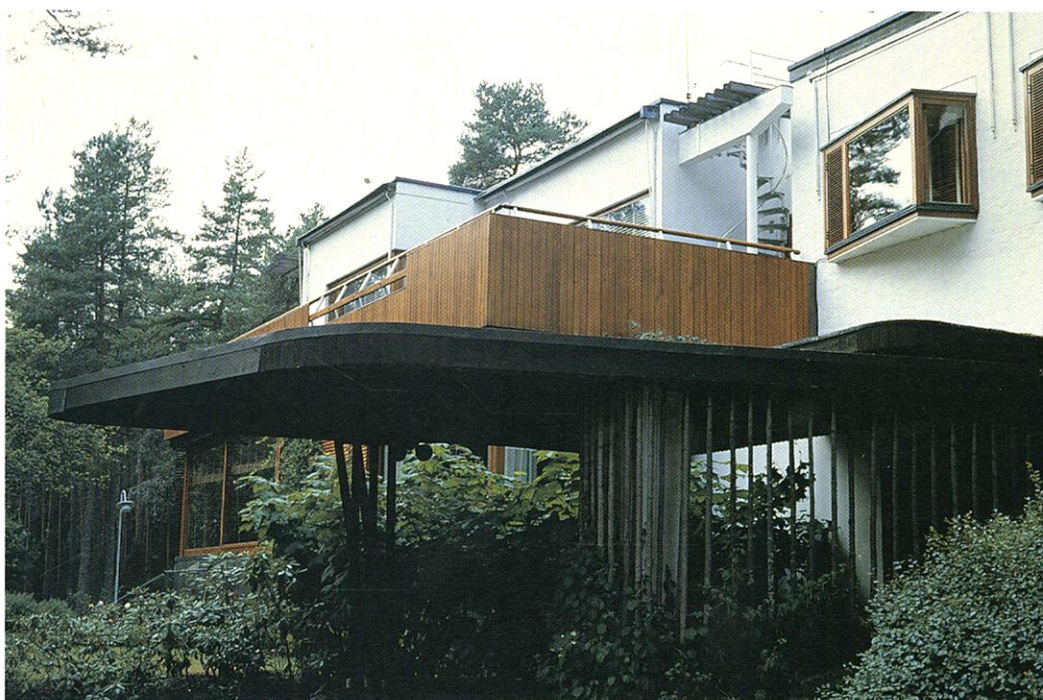
03 - MARQUESINA DE ENTRADA, CON EL SOPORTE COMPUESTO POR VARIOS "TRONCOS" ATADOS Y CON LA CELOSÍA DE VARETAS SIN DESBASTAR.
