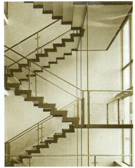
17 · DETALLE DE LA ESCALERA DEL AYUNTAMIENTO DE RODOVRE, DINAMARCA, 1954, DE ARNE JACOBSEN
