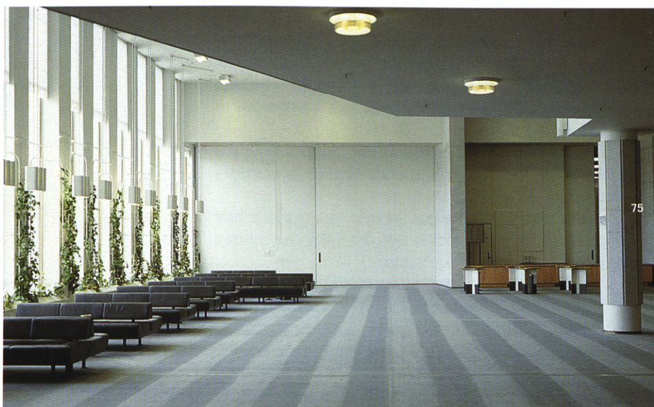
09 · DOS EJEMPLOS DE SOPORTES REVESTIDOS CON PLACAS DE PIEDRA EN EL INTERIOR DEL PALACIO DE CONGRESOS DE HELSINKI.
