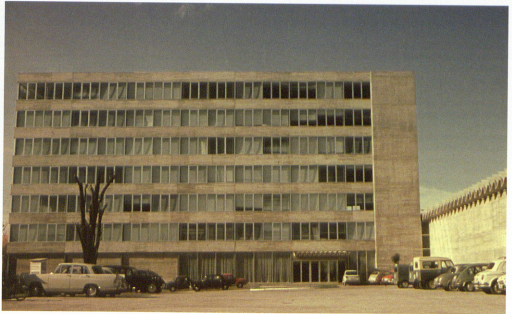
12 · VISTA EXTERIOR. ARCHIVO DE MIGUEL FISAC (1963)
