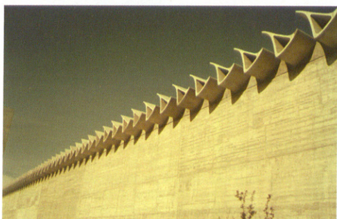
17 · VISTA EXTERIOR. ARCHIVO DE MIGUEL FISAC (1963)
