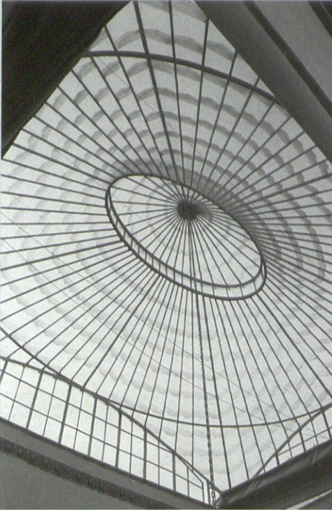
25 - MONTERA DE LA CASA UTHOFF. REFORMA ISABELINA SOBRE CASA NEOCLÁSICA
