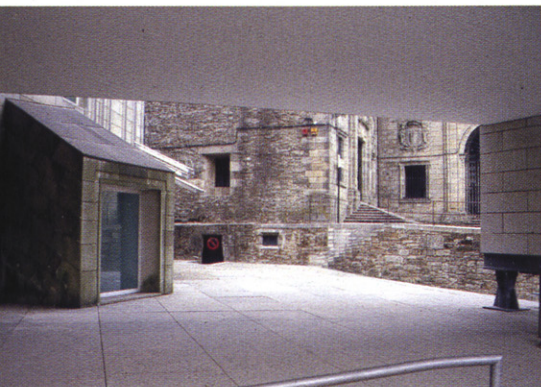
11 - CEGAC. VESTÍBULO DE ENTRADA
