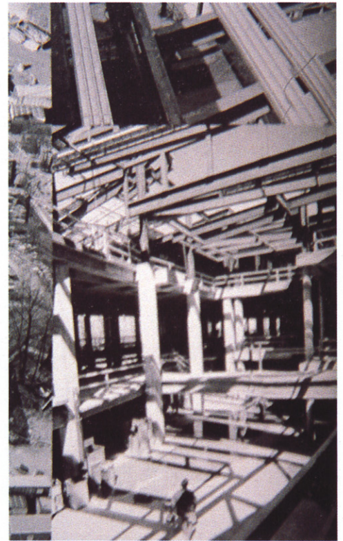
07 - ATRIO EN CONSTRUCCIÓN DE ARONOFF
