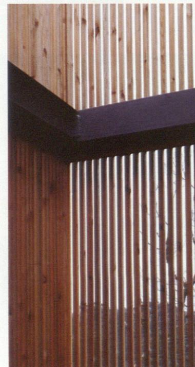
1. ESTRUCTURA PRINCIPAL. PERFILES DE ACERO LAMINADO 2UPN200 PAREADOS FORMANDO UN CAJÓN. IMPRIMACIÓN EPOXÍDICA 60 µM. CAPA ACABADO 40µM.
